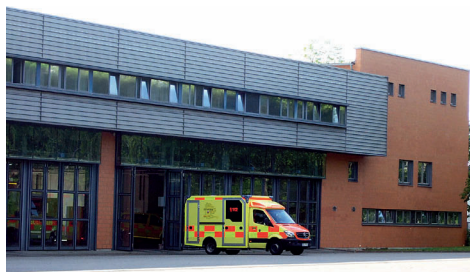
Abb./Rys. 57: Leitstelle Lausitz in Cottbus/Chóšebuz Stanowisko Kierowania Lausitz (Łużyce) w Chociebużu
